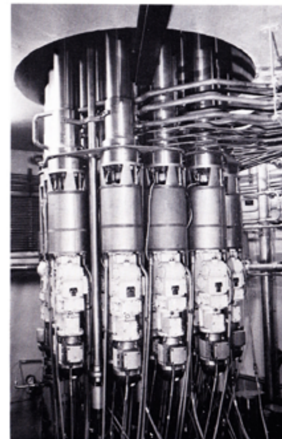
Steuerstabantriebe
